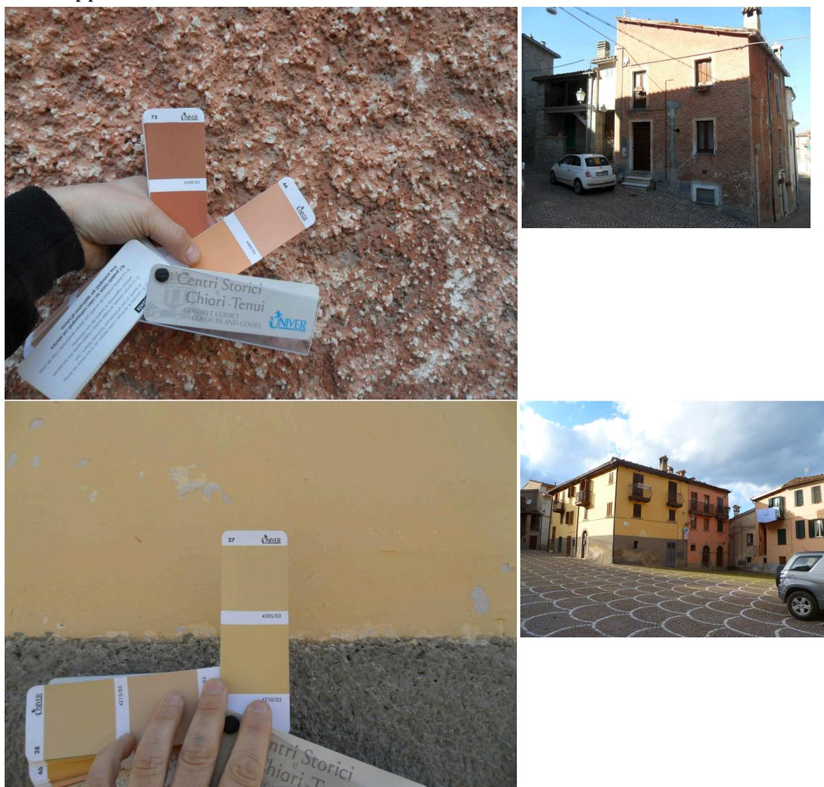
Figura 34 Rilievo analisi dei colori delle facciate del PdR
