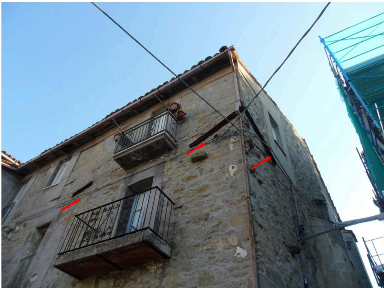
La mancanza di elementi tenso-resistenti orizzontali impedisce però di riportare i fondazione le forze agenti nelle zone triangolari alte della parete, determinando così una elevata vulnerabilità sismica di tali zone.
