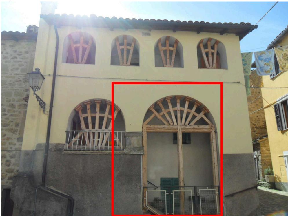
Si tratta della tipologia strutturale denominata “prima classe”. Le tipologie di volte più diffuse sono le cilindriche semplici (a botte) ovvero composte (a padiglione o a crociera) e quelle a doppia curvatura (di traslazione o rotazione).
