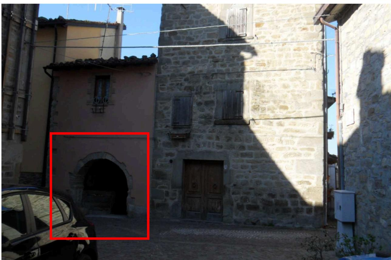
Se l'arco è ben disegnato le sezioni sono tutte compresse e non insorgono sforzi di trazione deleteri per la muratura. Tutti questi vantaggi però si pagano con una spinta all'imposta notevole e, se i
