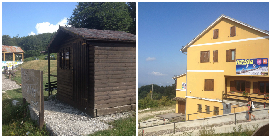
Figura 3-1 Le strutture esistenti a Prato Selva nei pressi del parcheggio
