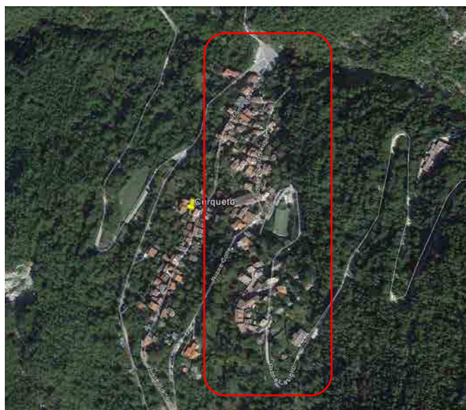
Viabilità all'interno della frazione di Cerqueto
